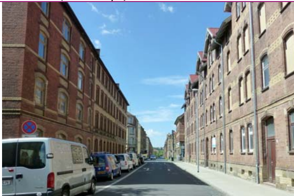
Abb. 32 Geschlossene Gründerzeitbebauung in Gotha-Ost (Steinstraße)
