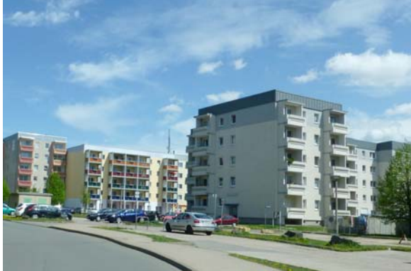
Abb. 35 Wohnen im sanierten Geschosswohnungsbau der 1980er/90er Jahre (Siebleben)
