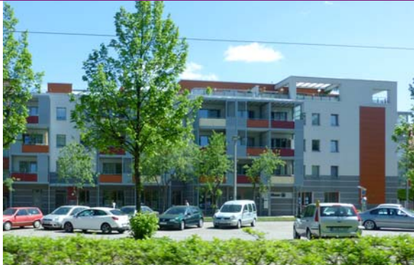
Abb. 36 Aufwändig sanierter Geschosswohnungsbau der 1990er Jahre (westliche Altstadt)
