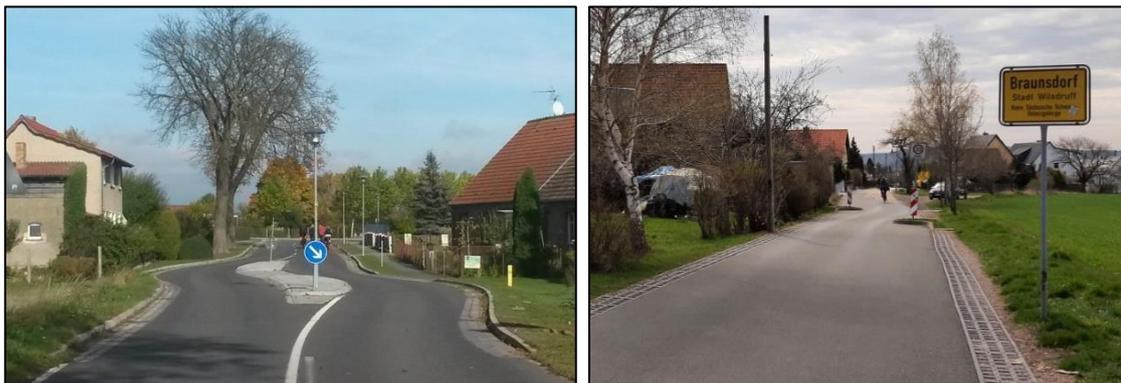
**Abb. 18** Beispiele geschwindigkeitsdämpfende Ortseingangsgestaltung
