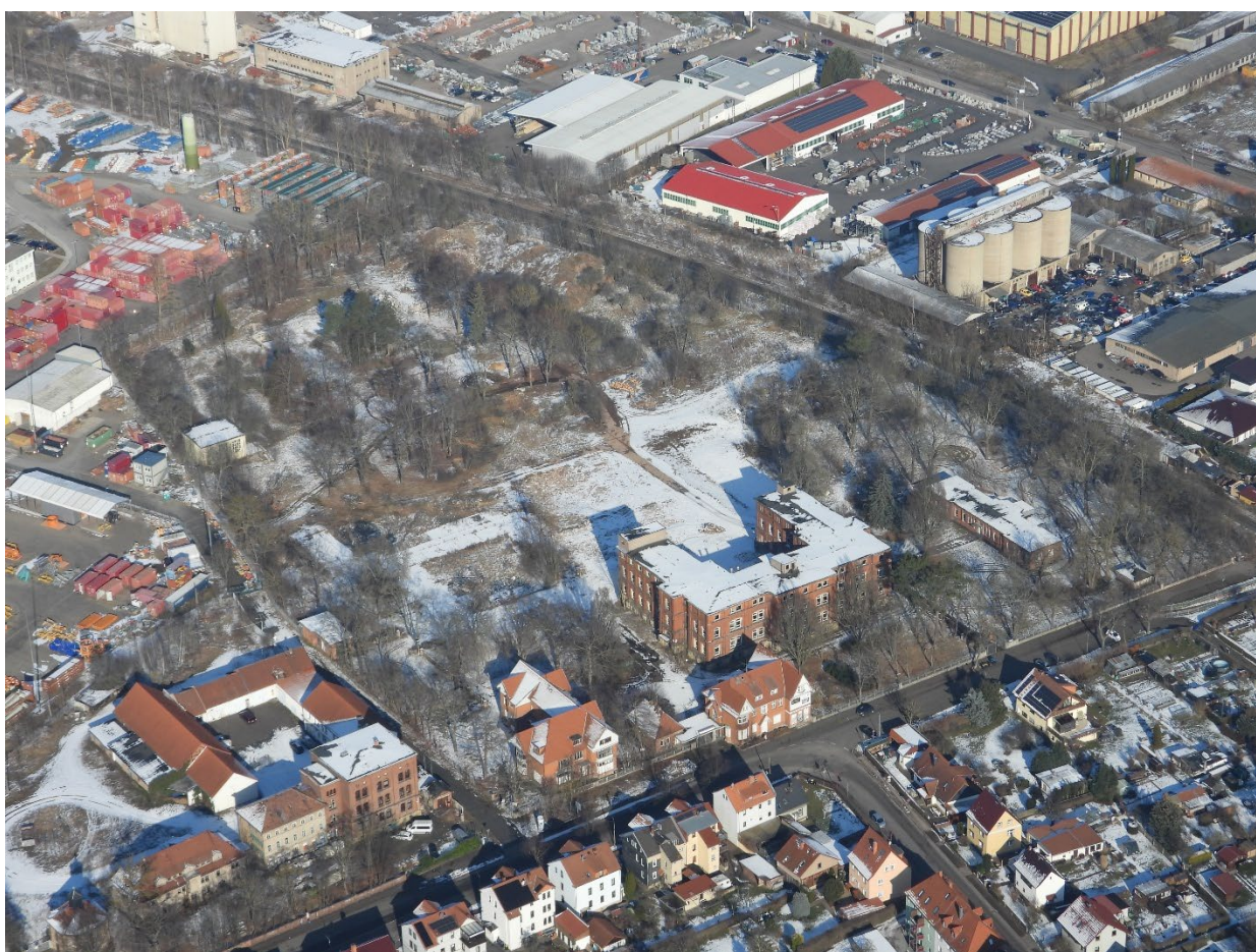
Abb. 4: Überblick Plangebiet Ri. NO, Luftbildschrägaufnahme R. Bellstedt, 2025
